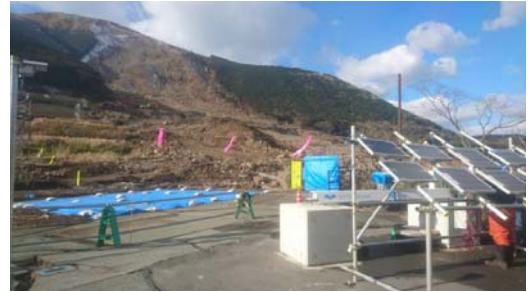
図 5 南阿蘇村立野地区に設置した GB-SAR Fig. 5 GB-SAR system installed at Minami-Aso.
