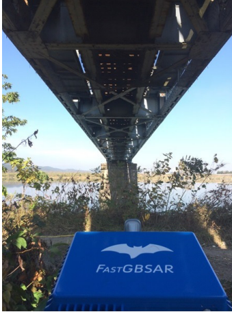
図 10 鉄道橋梁に設置したレーダ装置 Fig. 10 Radar system installed near a bridge.
